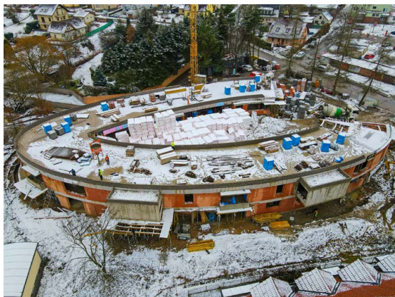
Stavba Domova Pomněnka (leden 2023)
