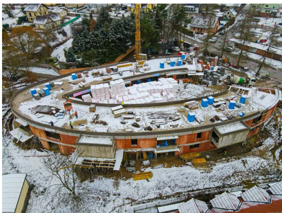
Stavba Domova Pomněnka (leden 2023)
